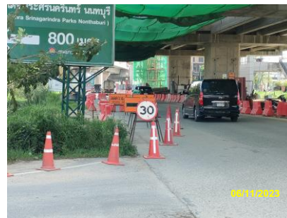
การติดตั้งสัญลักษณ์ป้ายเบี่ยงช่องทางจราจร
